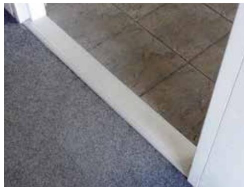
Cette rampe est utilisée pour remplacer les pas de seuil dans la maison ou pour franchir de faibles dénivellations, par exemple pour former une jonction entre différents types de revêtements de sol, tels qu'un sol carrelé, de la moquette.
